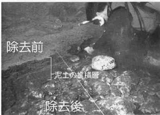
図5 泥土の除去作業風景
